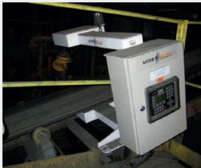
MoistScan® MA-500HD instalado en la cinta transportadora de alimentación de la planta en una refinería de mineral de níquel. Los datos del MoistScan® se utilizan para controlar el tiempo de residencia del mineral en un secador rotatorio.
